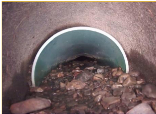
Figure 23: Exemple de niveau 5 – fonctionnel PACP®
