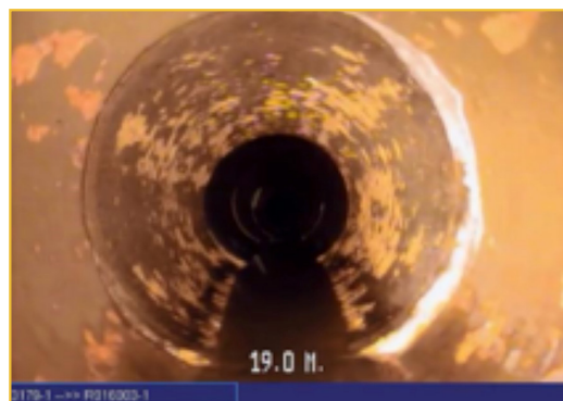
Figure 34 : Éclairage suffisant et bien réparti sur la circonférence
