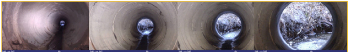
Figure 5: Exemples d'inspection par caméra TO – analyses concluantes
