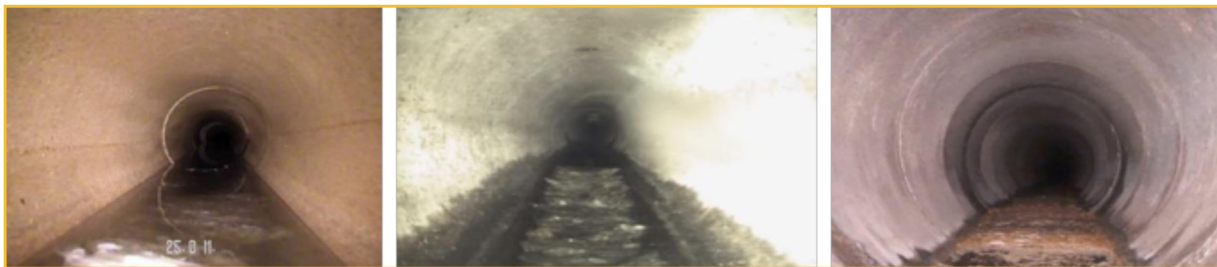
Figure 30: Exemples de conduites dont le nettoyage est incomplet
