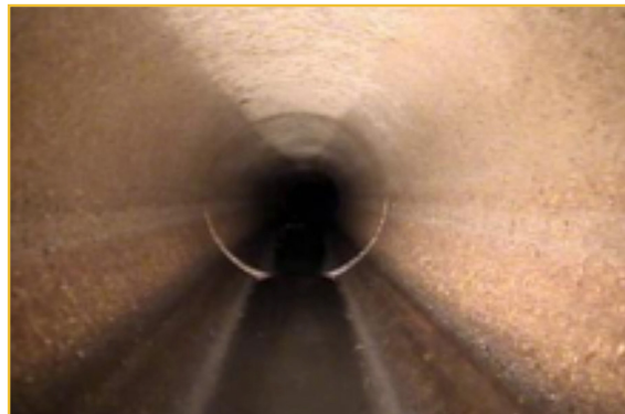
Figure 29: Exemple d'une conduite bien nettoyée
