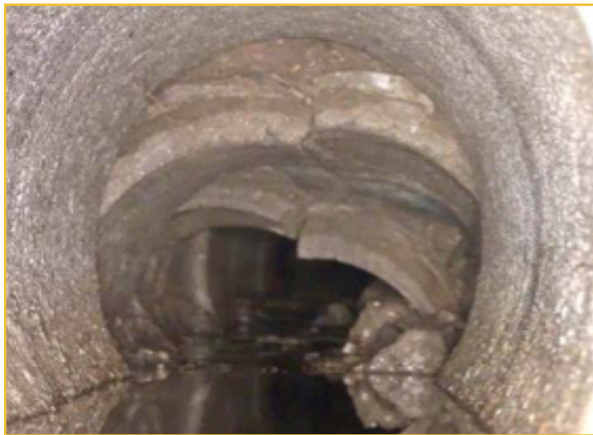
Figure 22: Exemple de niveau 5 – structural PACP®
