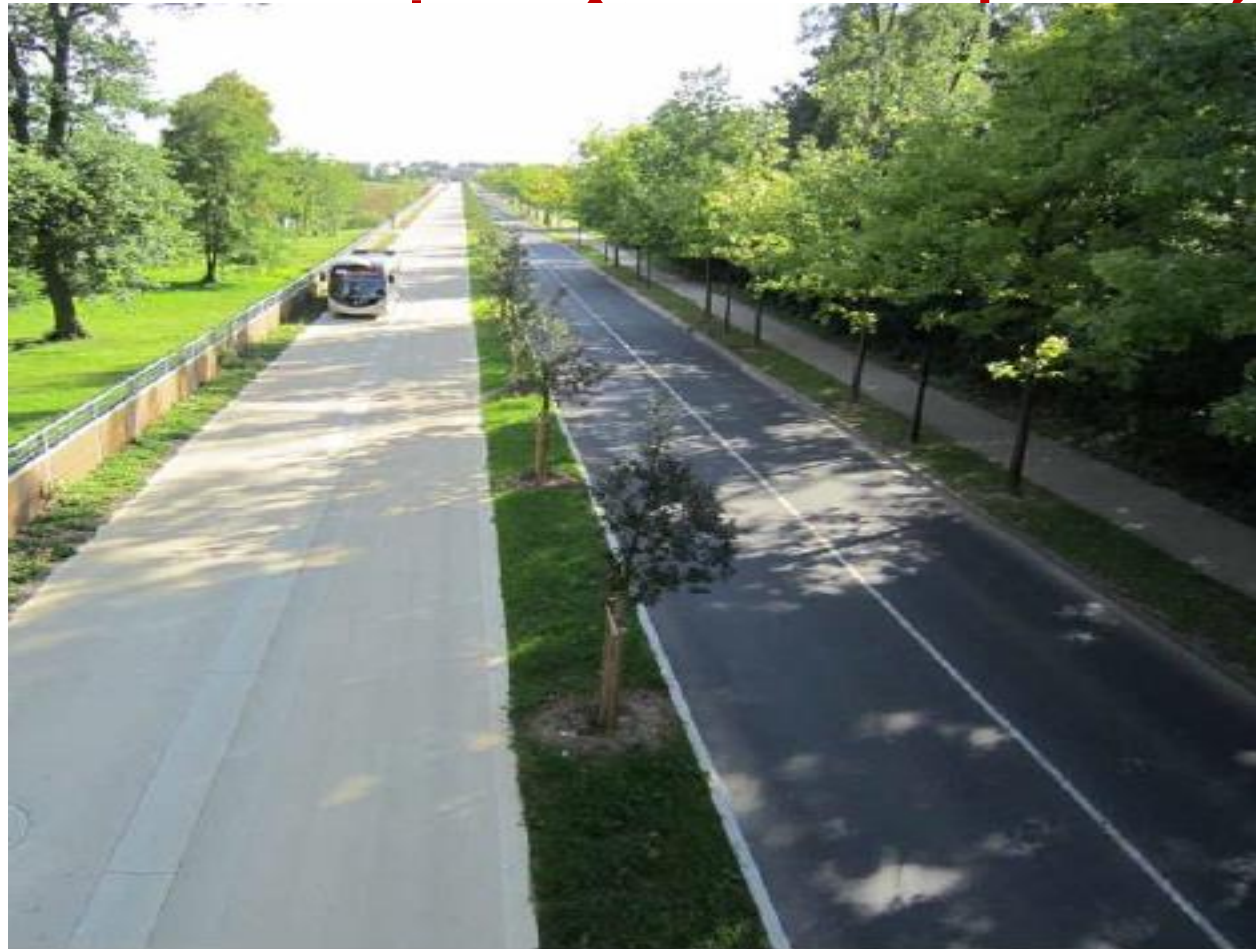
Bétons coulés en place
