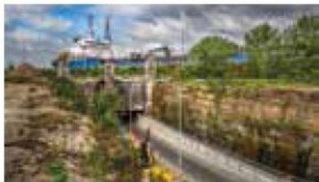
6 Tunnel de Melocheville
