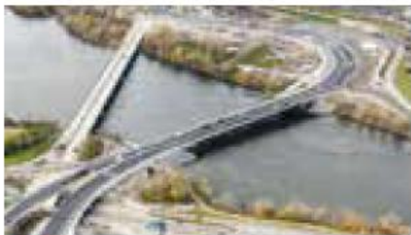
3 Pont de contournement de l'île des Sœurs
