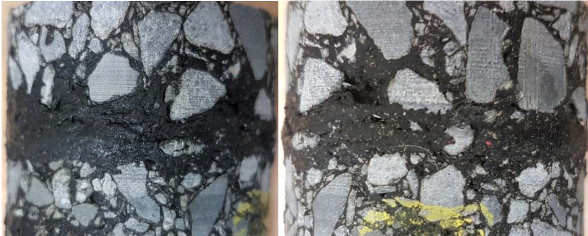
Figure 9 : Exemples de fissurations et décollements causés par le carottage (éprouvettes de 50 mm de diamètre)
