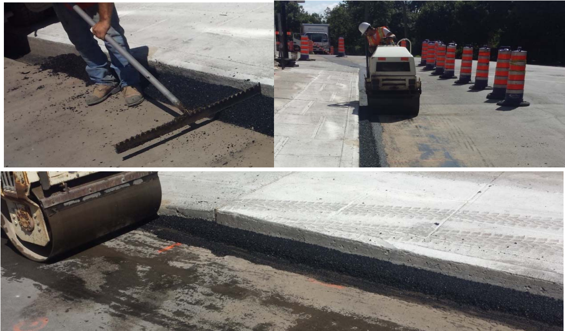
Figure 7 : Préparation de la couche finale et compaction graduelle au rouleau
