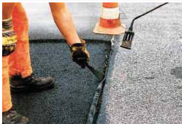
Figure 1.5 Profil de la bande bitumineuse Tok-Band Spezial (Denso (2014))
