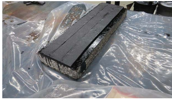
Figure 4.9 La bande est posée après 20 minutes de séchage de l'apprêt.
