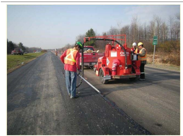
Figure 1.9 Machine de pose d'adhésif pour joint en fonctionnement (source : Crafcoc)
