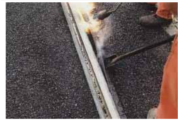
Figure 1.7 Profil de la bande bitumineuse Tok-Band T (Denso (2014))
