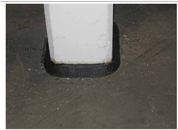
Figure 1.6 Profil de la bande bitumineuse Tok-Band Spezial DR (Denso (2014))
