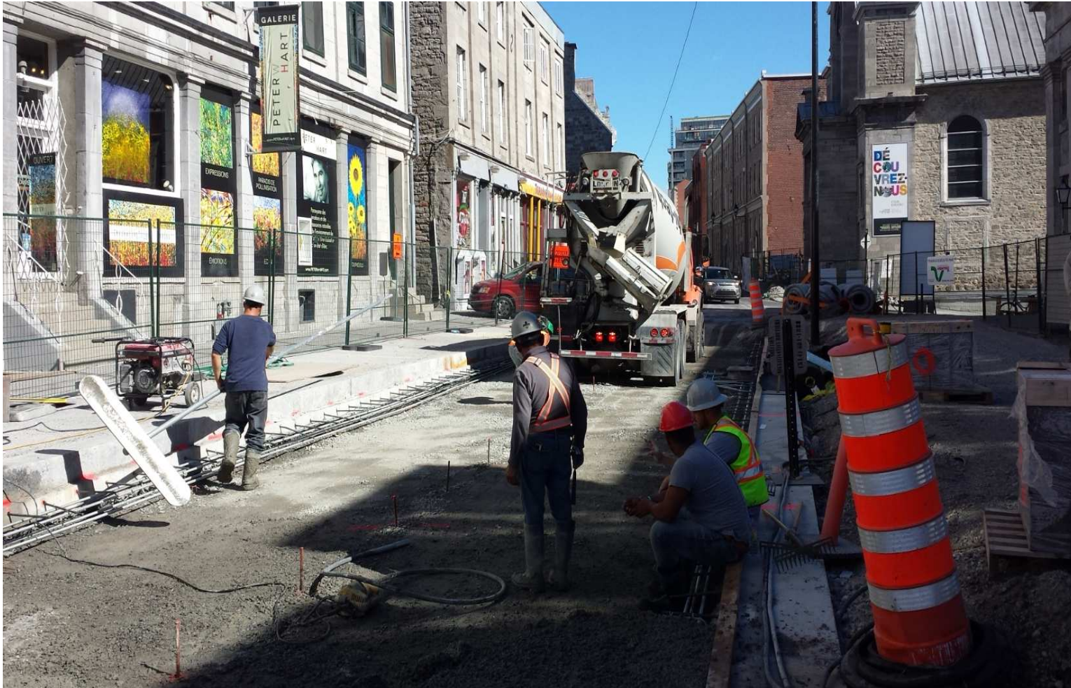
Bétonnage du béton renforcé des fibres d'acier déversement direct sur l'assise
