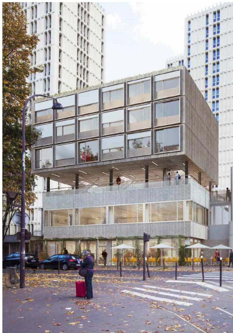
Projet « Le Relais Italie » (surélévation bois), Ancien Conservatoire du 13e
