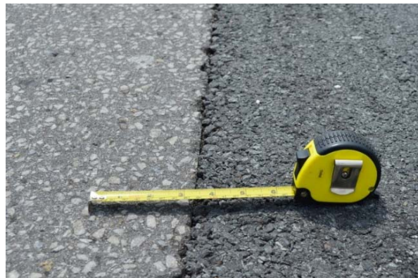
Figure 7 : Chaînage 0+020 à 0+030; Ouverture du joint de 0 à 10 mm
