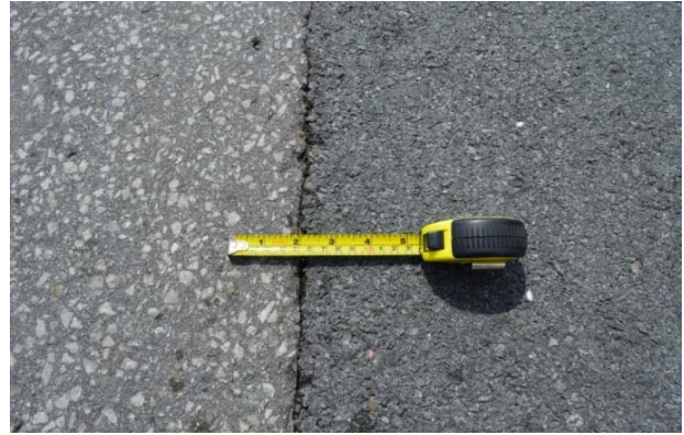
Figure 6 : Chaînage 0+010 à 0+020; Ouverture du joint de 0 à 10 mm
