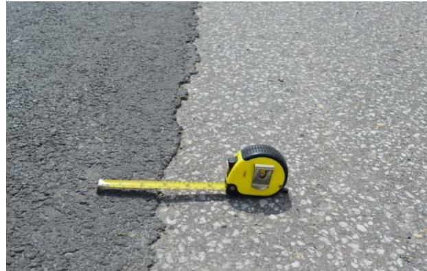
Figure 8 : Chaînage 0+030 à 0+040; Ouverture du joint de 0 à 15 mm
