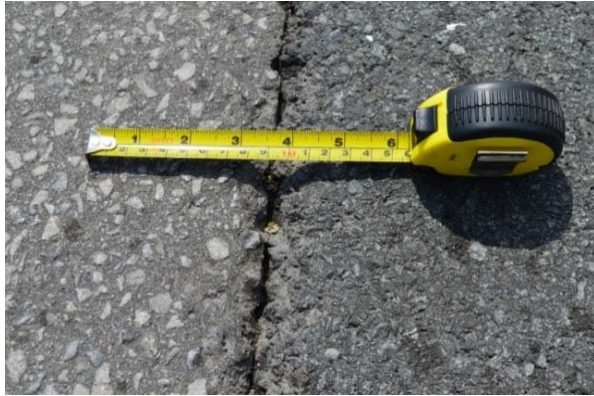
Figure 5 : Chaînage 0+000 à 0+010; Ouverture du joint de 5 à 10 mm
