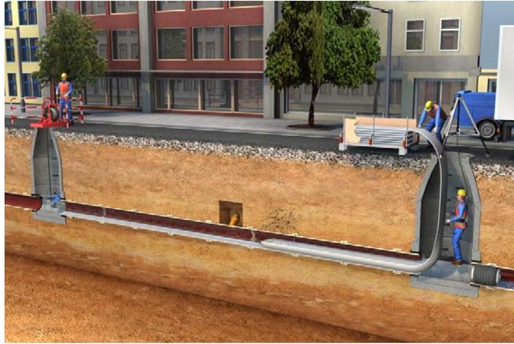
Figure 18 – Insertion de la gaine dans la conduite à réhabiliter
