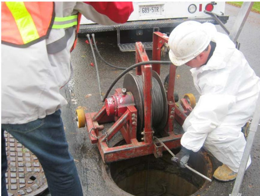
Figure 20 – Treuil utilisé pour tirer la gaine
