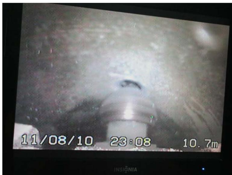
Figure 30 – Ouverture d'un raccordement à l'aide du robot
