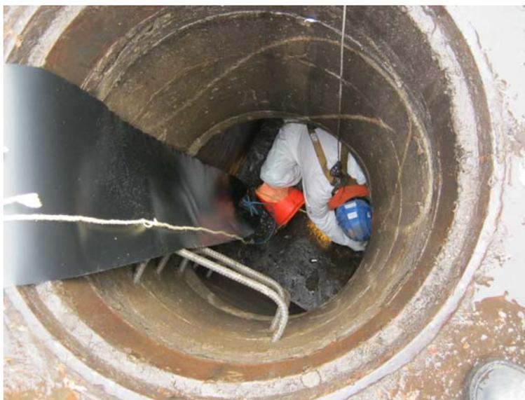
Figure 16 – Mise en place du polythène d'insertion
