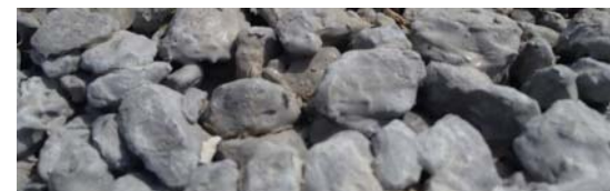
Béton avant traitement
