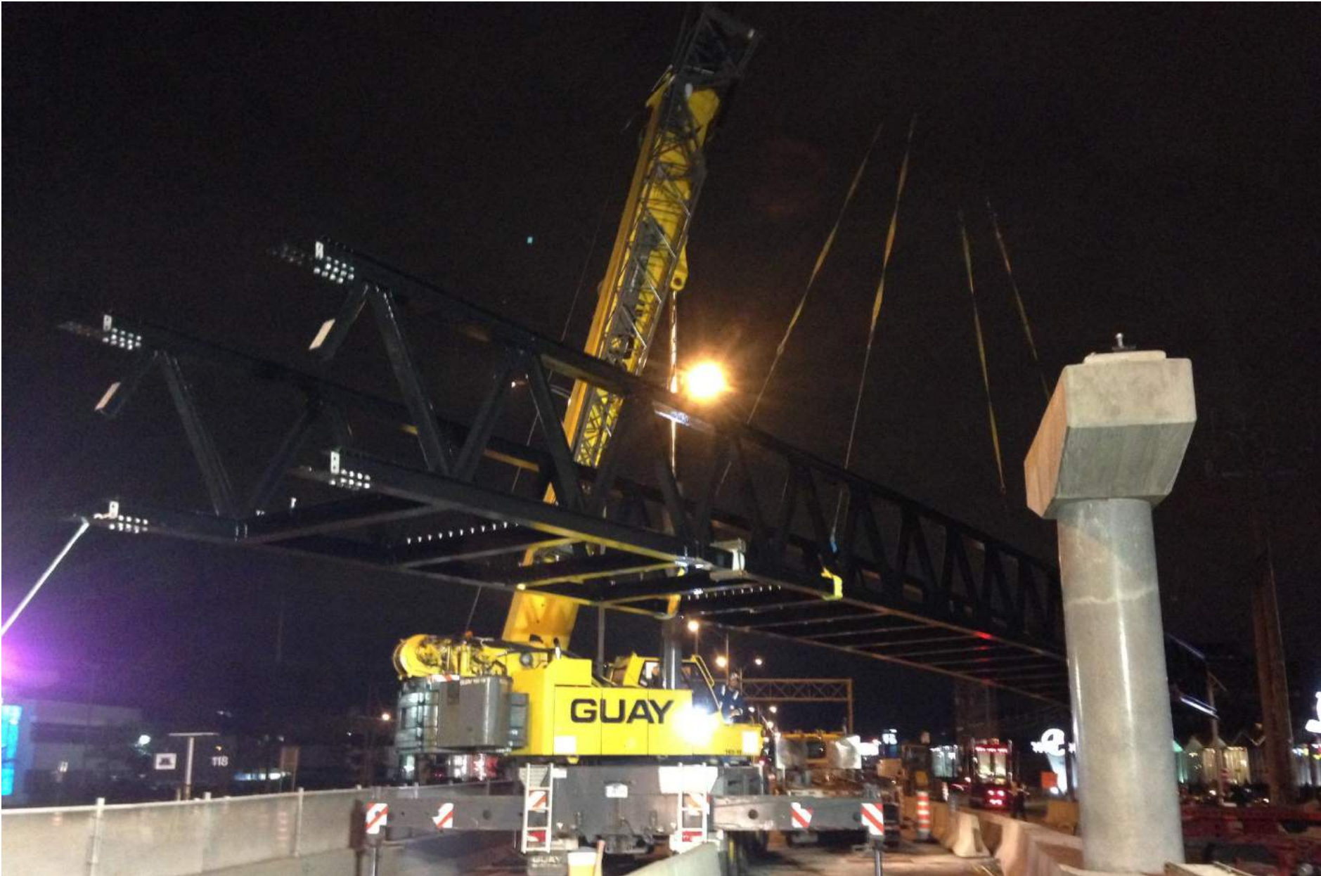
Installation de la charpente d'acier
