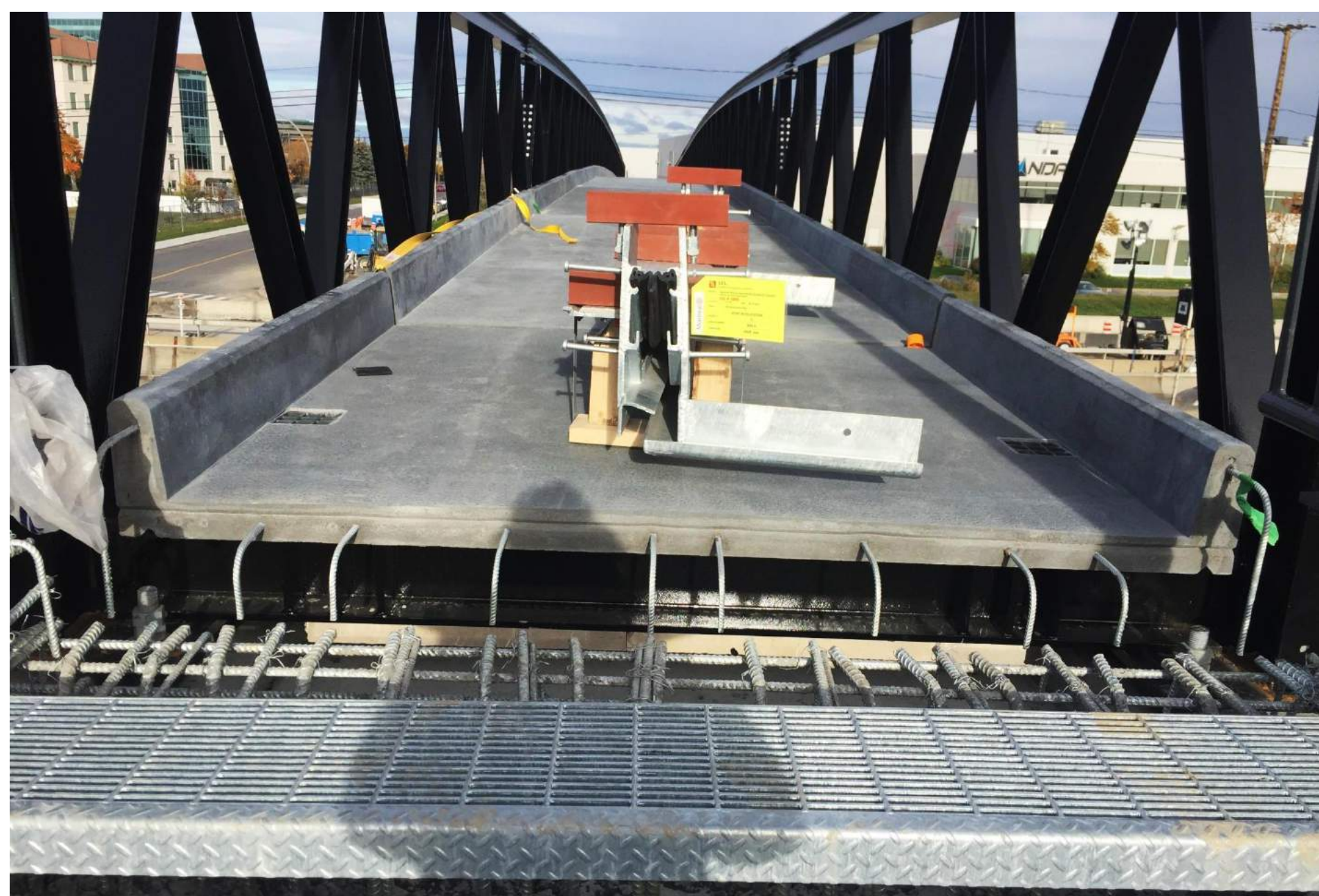
Installation des dalles
