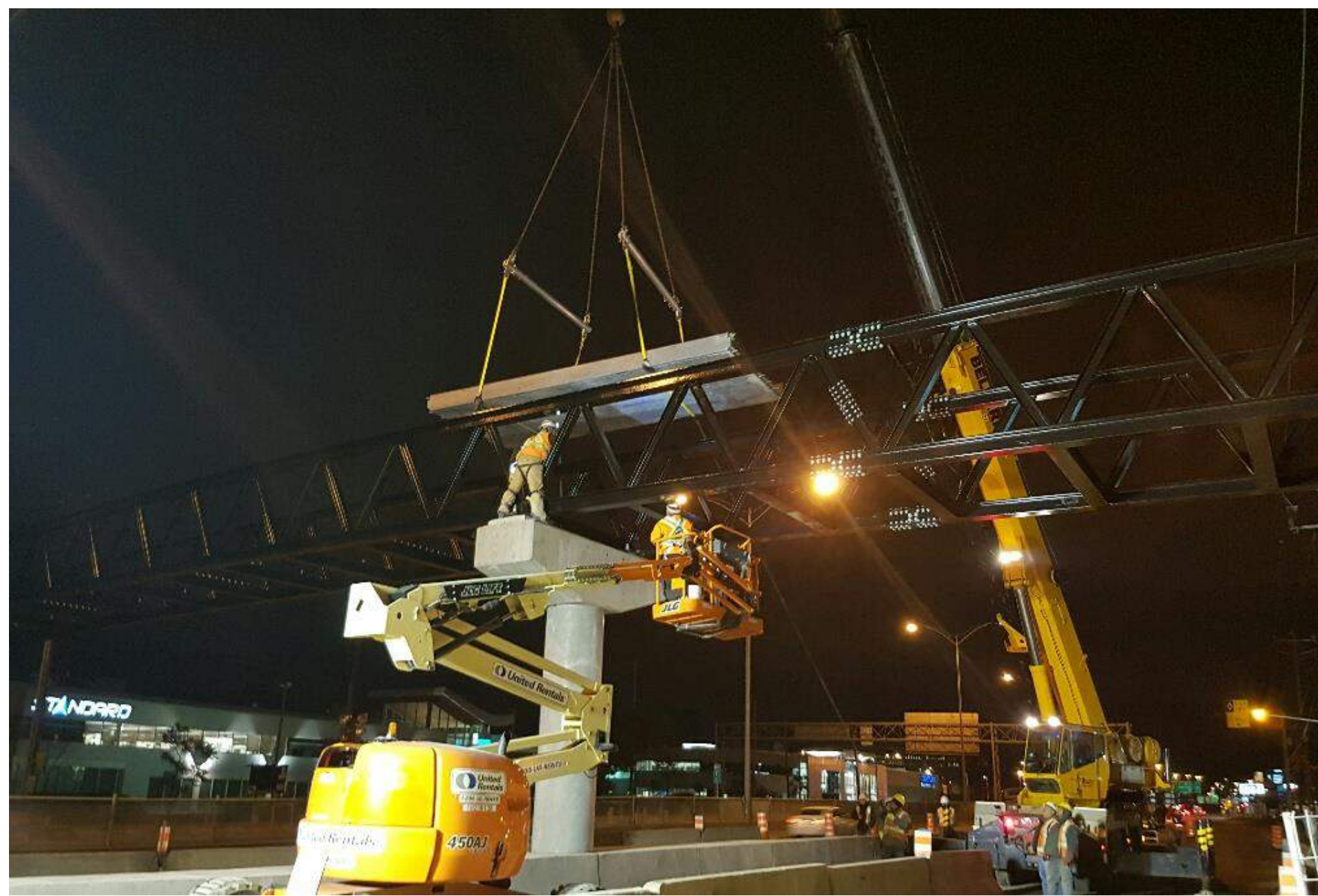
Installation des dalles
