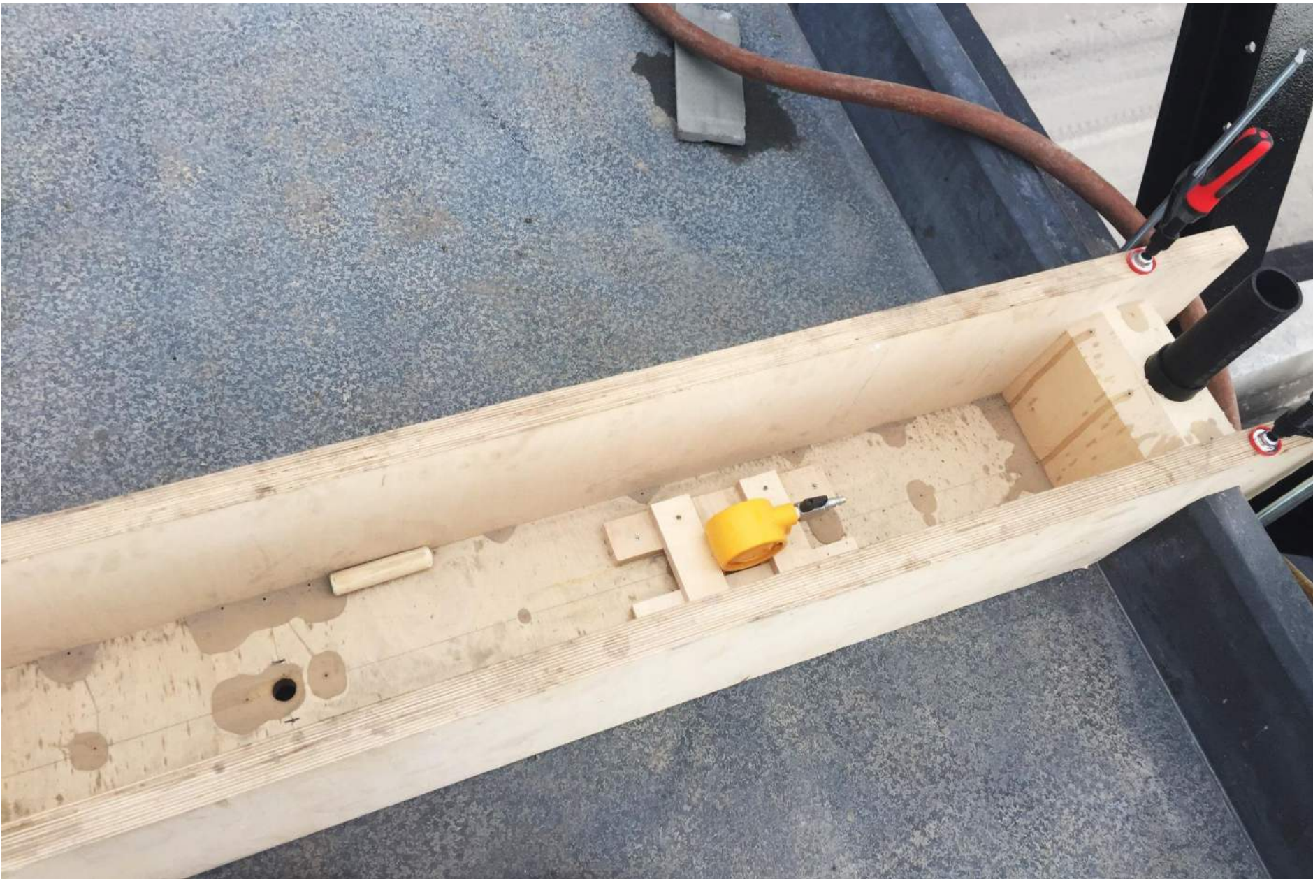
Bétonnage des joints
