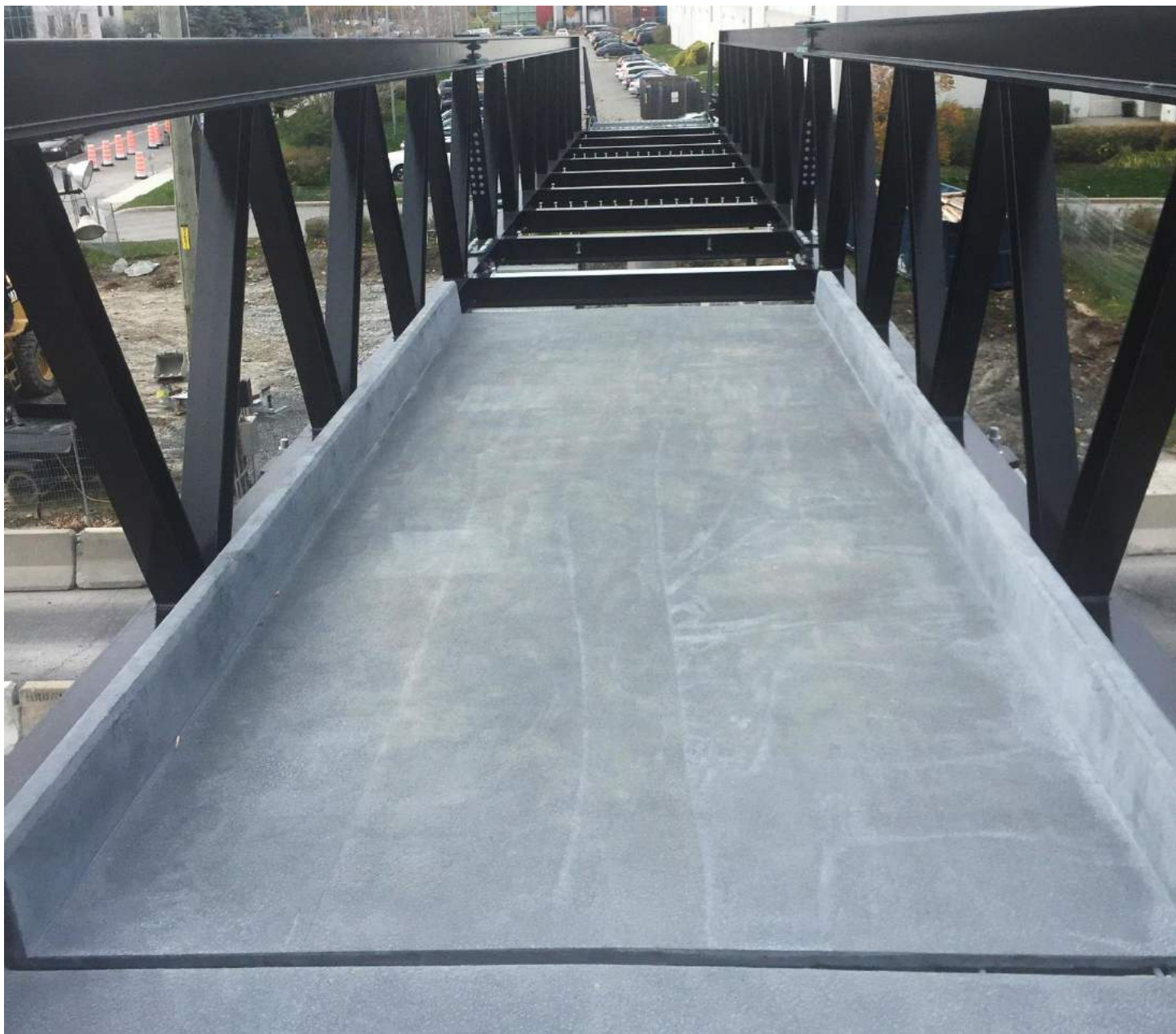
Installation des dalles
