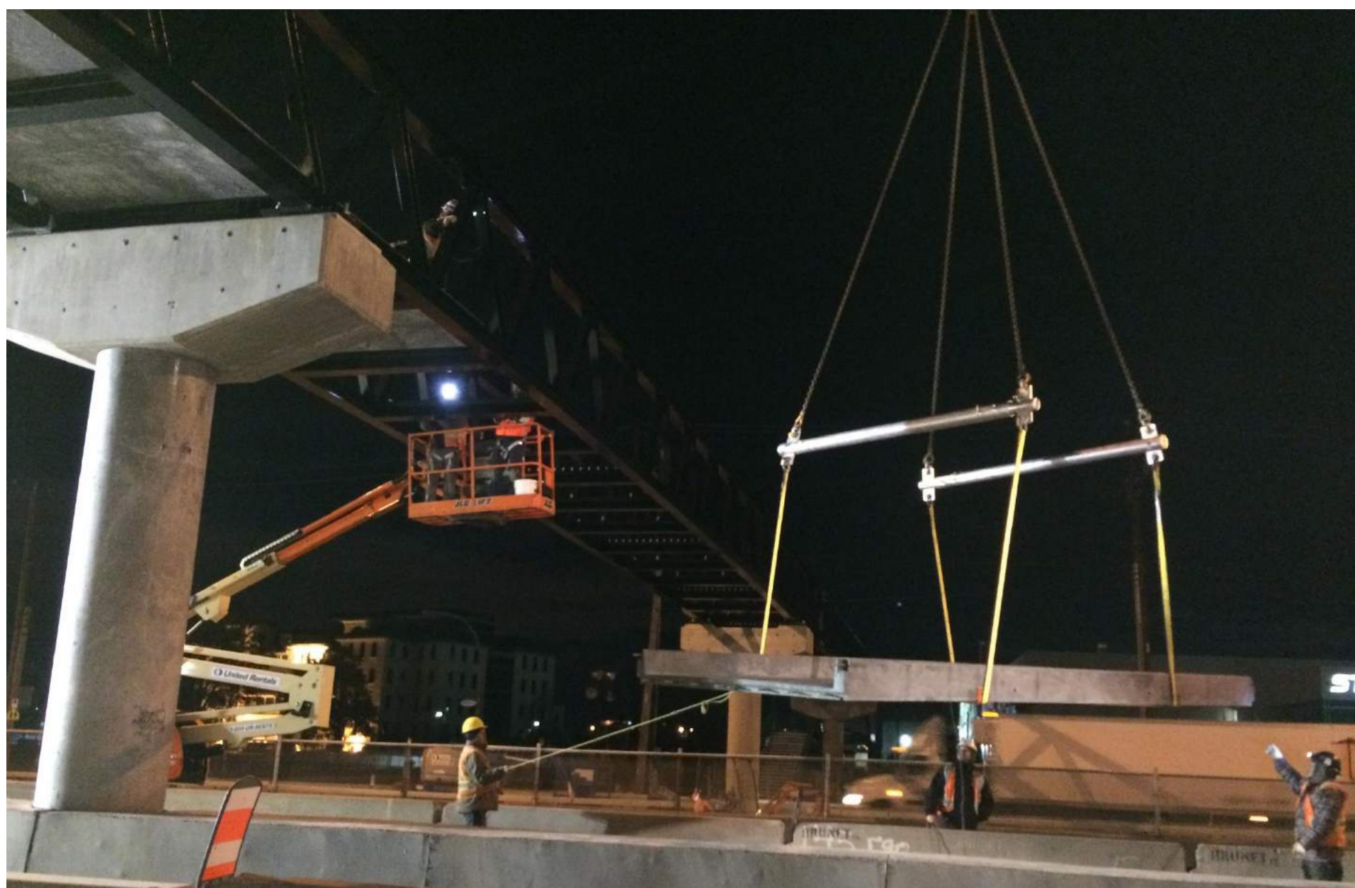
Installation des dalles
