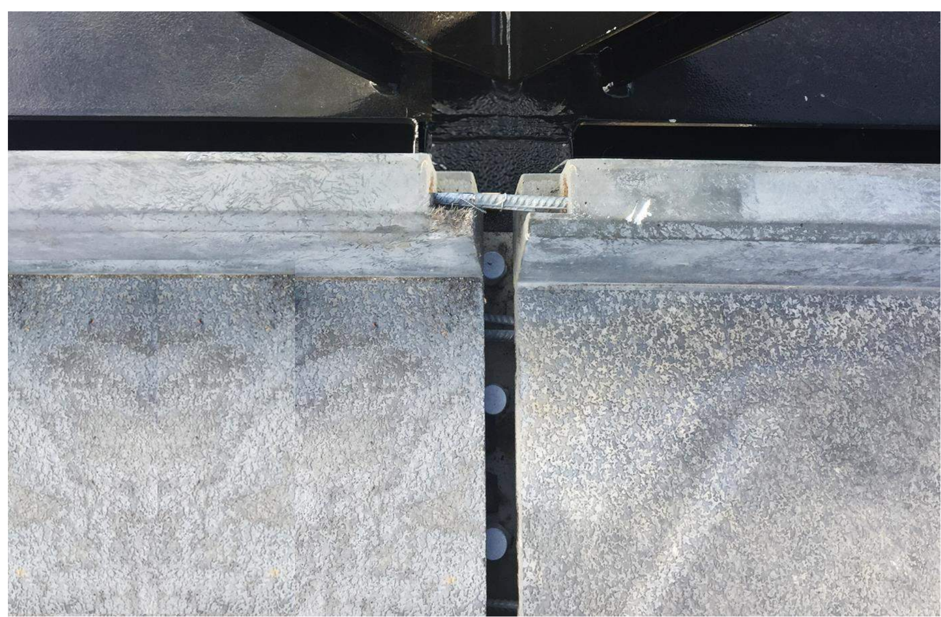
Bétonnage des joints
