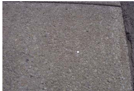
Figure A5-2 : Surface d'un trottoir après scarification meulage
