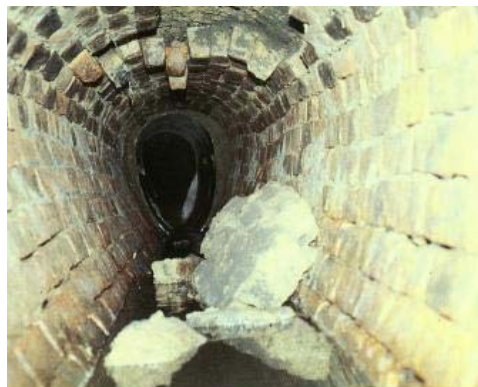
Figure 7 – Exemple d'obstruction
