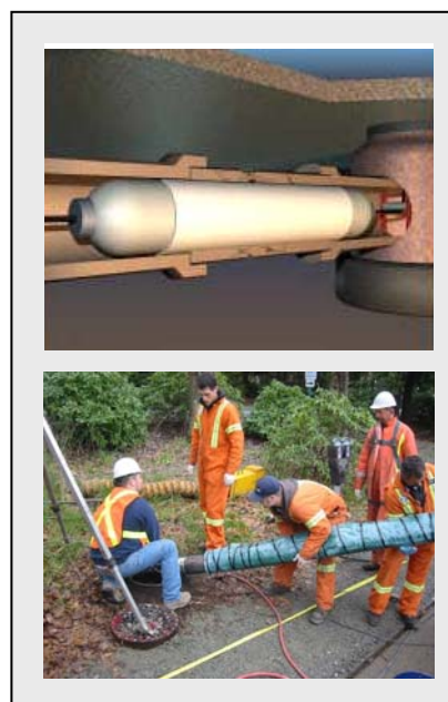
Figure 56 – Exemple de chemisage ponctuel
