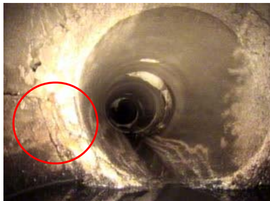
Figure 61 – (Photo 1) Armature visible de 8 h à 9 h
