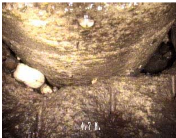
Figure 64 – (Photo 4) Raccordement à la masse déféctueux et pénétrant - Armature apparente
