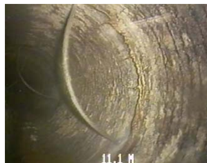
Figure 27 – Exemple de corrosion par une attaque au H_2S
