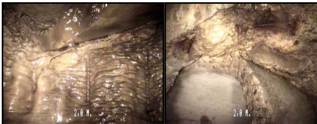
Figure 62 – (Photo 2) - Raccordement à la masse déféctueux et pénétrant / Dépôts attachés - incrustation / Armature visible / Suintement
