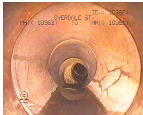
Figure 18 – Exemple de fissures multiples de 3 h à 5 h
