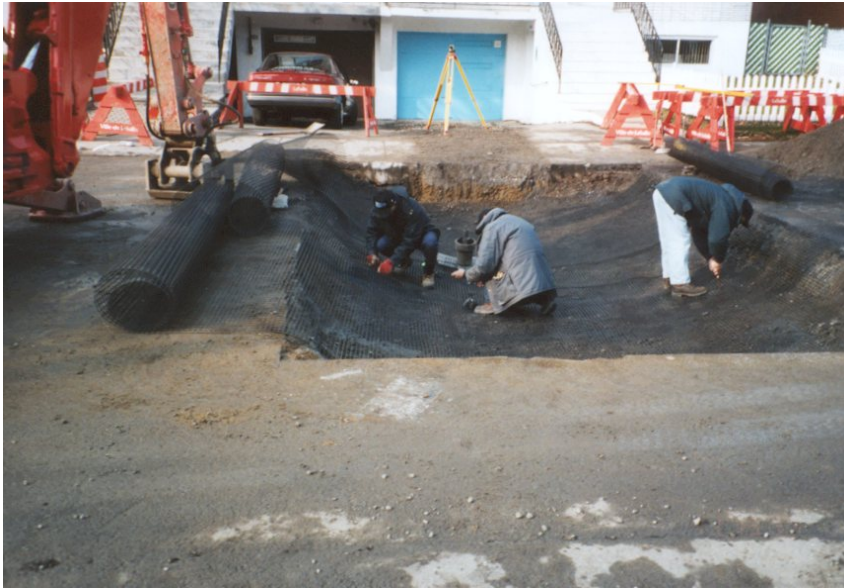
Figure 5.2 : L'utilisation des géosynthétiques pour renforcer les tranchées
