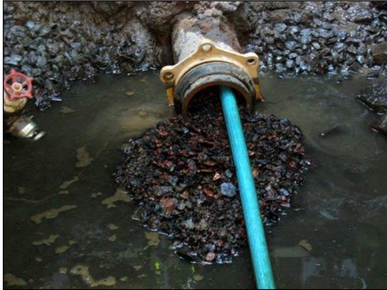
Figure 2 – Nettoyage de la conduite à basse pression d'eau
