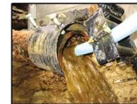
Nettoyage exhaustif de la conduite avec eau pressurisée. Un puit d'accès est requis à chacune des extrémités de la conduite. Retour du service d'eau aux usagers dans la journée des travaux, ou installation d'un réseau d'alimentation temporaire.
