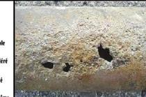
Au besoin, réparation des trous et des fissures à l'intérieur de la conduite avec une mini-gaine.
