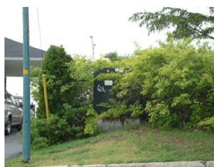
Photo du même aménagement en 2002
