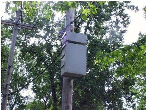
Pile pour coaxial de Vidéotron
