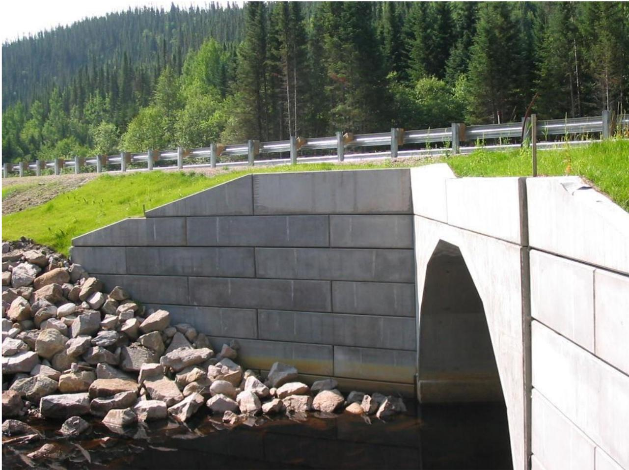
**Les murs de soutènement peuvent être intégrés à des structures de types ponceaux.**
