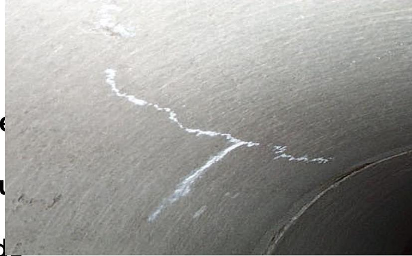
Le phénomène de scellement des fissures par des cristaux de carbonate de calcium s'opère à la suite d'une réaction chimique entre la chaux libre (hydroxyde de calcium) dans le béton et le bioxyde de carbone en présence d'humidité. Ce scellement des fissures par les cristaux de carbonate de calcium est appelé autocolmatage ou autocicatrisation.
