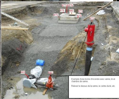
Exemple d'une borne d'incendie avec vanne, ts et chambre de vanne. Reliever le dessus de la vanne, le centre du ts, etc.
