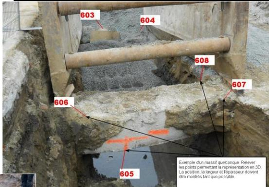
Exemple d'un massif quelconque. Reliever les points permettant la représentation en 3D. La position, la largeur et l'épaisseur doivent être montrés tant que possible.
