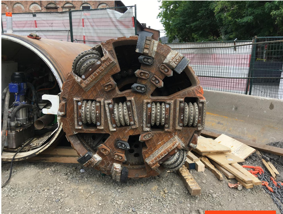
À l'arrivée au chantier
