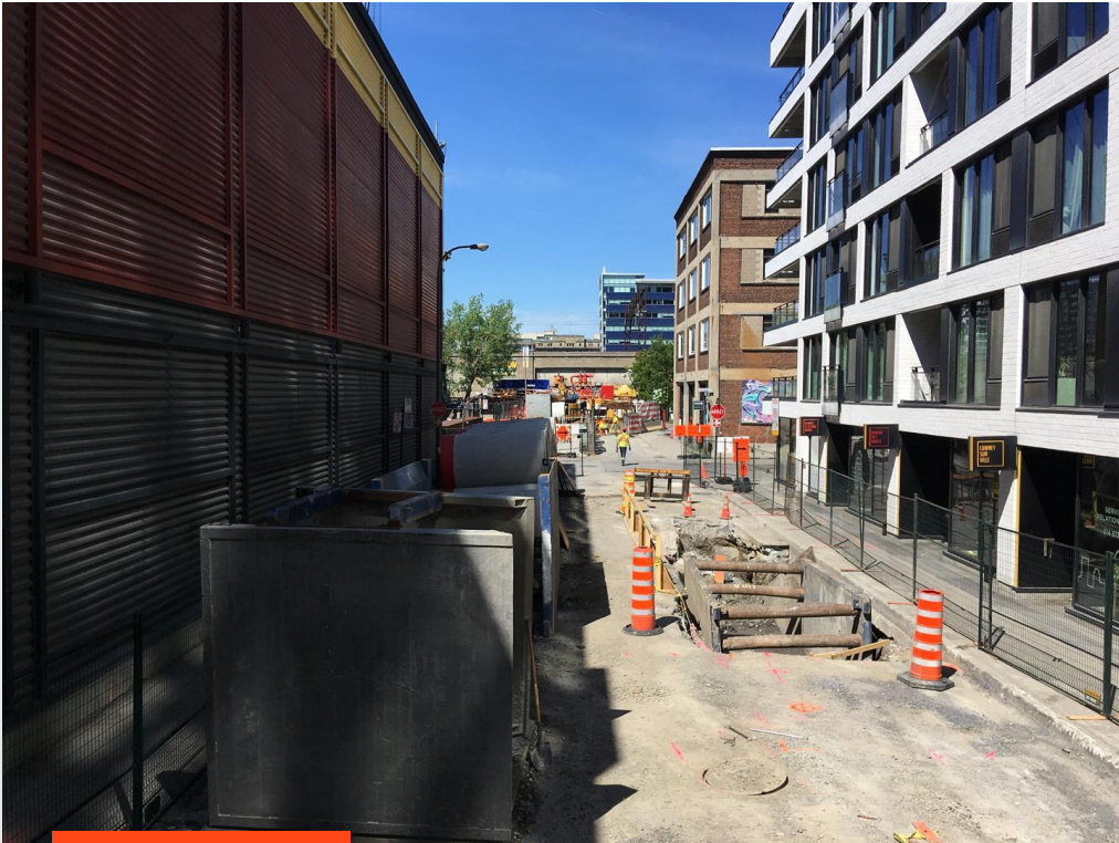
Site, excavation pour dégager le microtunnelier
