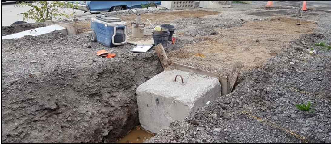
**Figure 7-12 RSR des sections #1 et #2 retenu par des planches de coffrage et des blocs de béton**
