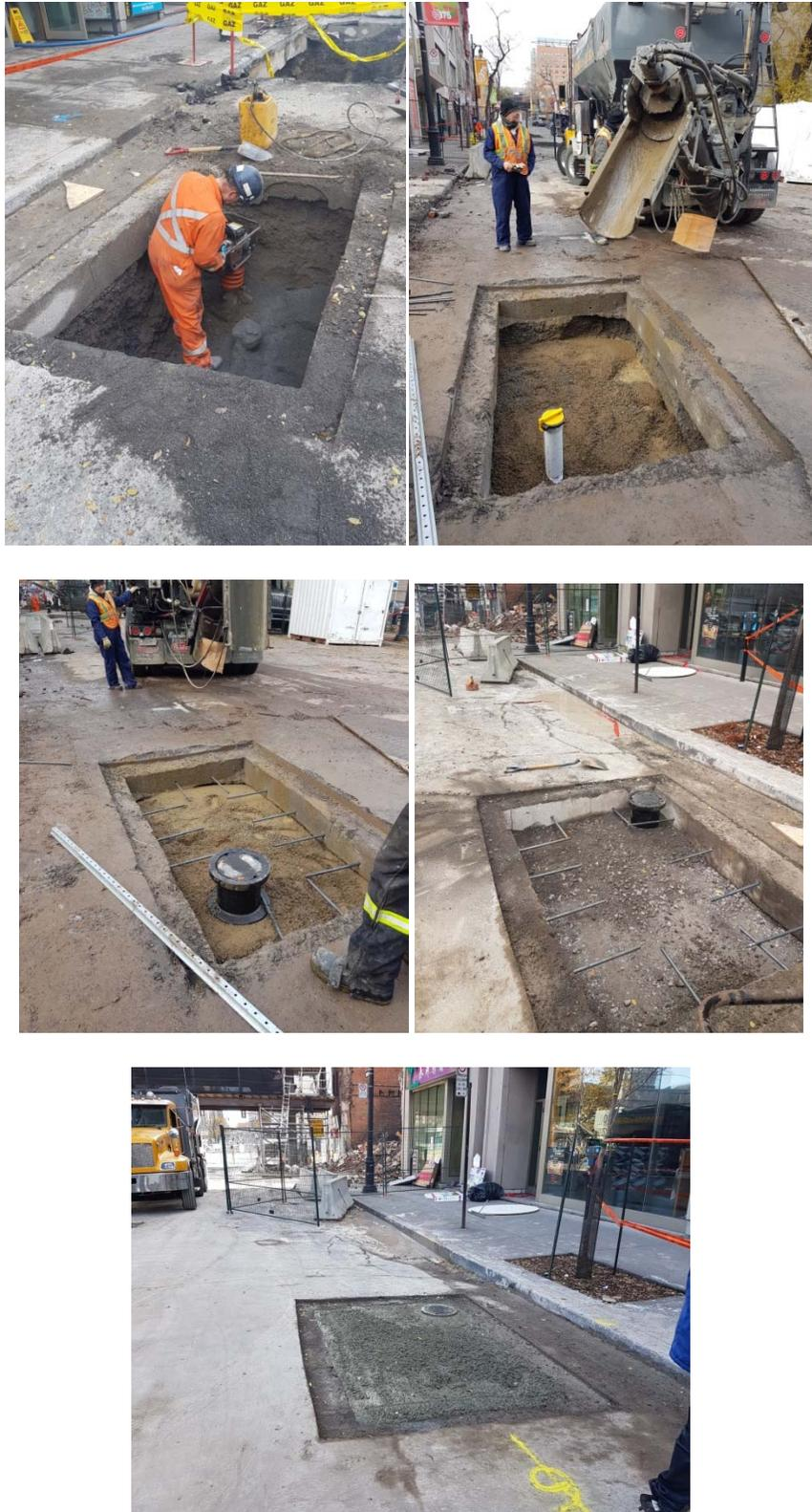
**Figure B5 : Installation dans une chaussée qui comporte une dalle de béton, 998 boulevard Saint-Laurent (site E)**
