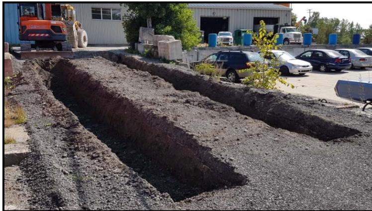
**Figure 7-2 Tranchées expérimentales sèches (2 x 17 mètres)**
