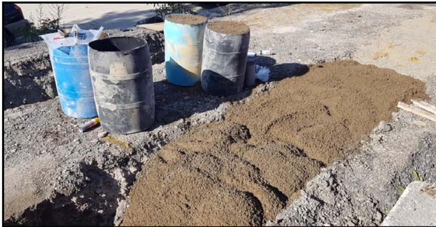
Figure 7-1 Remplissage de la tranchée #5 et de ses échantillons (barils)
