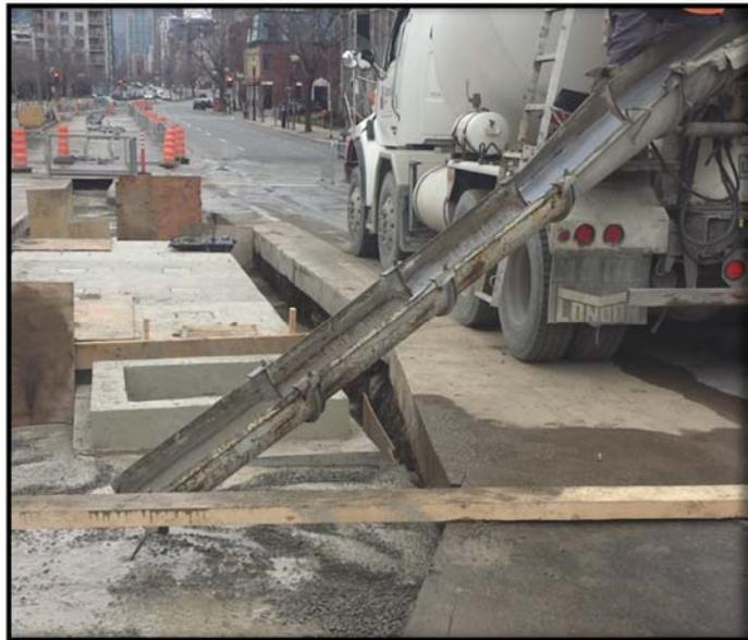
**Figure A3 : Remblaiement d'un puits d'accès préfabriqué inséré dans une ouverture étroite**
