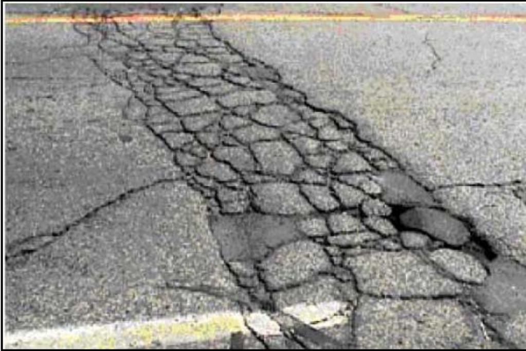
**Figure 2-9 Exemples de détérioration d'une chaussée suite à un mauvais remblai de tranchée au Québec (Fourny, 2008)**
