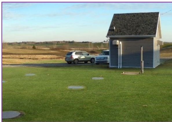
Figure 51 : Fosses septiques en amont d'une technologie brevetée Bionest
