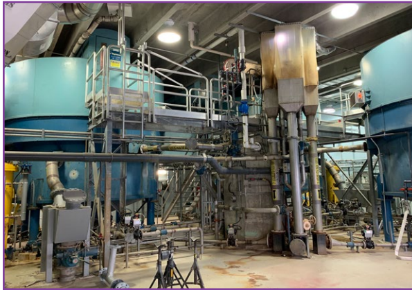
Figure 56 : Flottateurs
