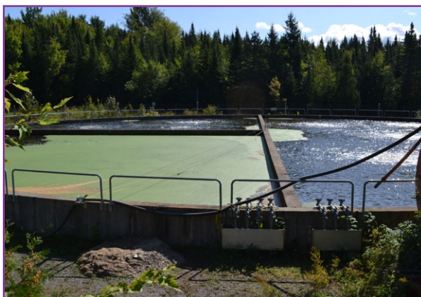
Figure 53 : Bassin d'aération (Catégorie A)
