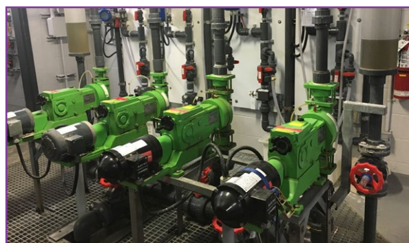
Figure 15: Équipements de dosage d'alun
