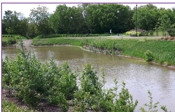
Figure 70 : Bassin avec retenue permanente (Bassin de rétention)
