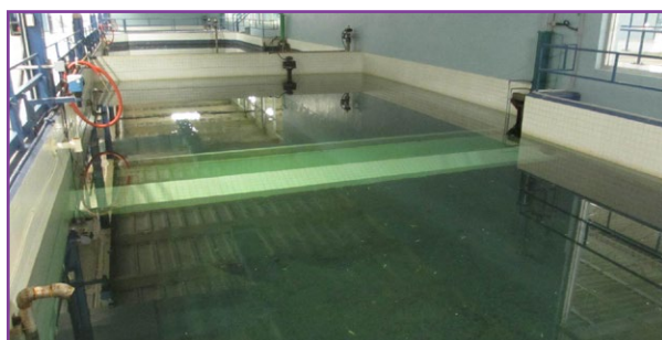
Figure 20 : Réservoirs de filtration (1)
