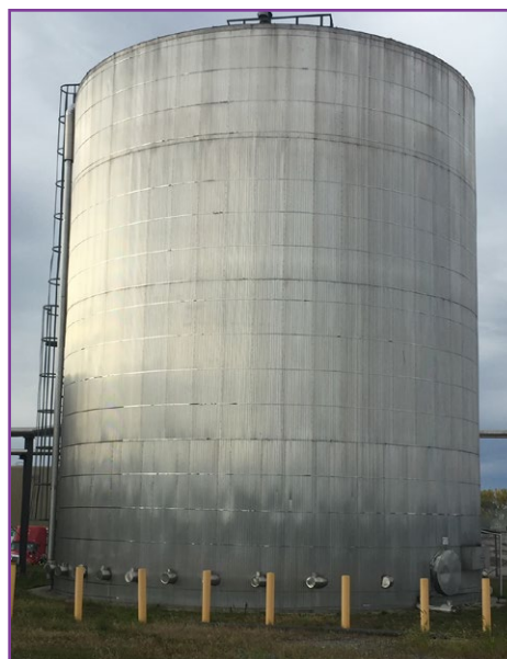
Figure 58: Digesteur anaérobie
