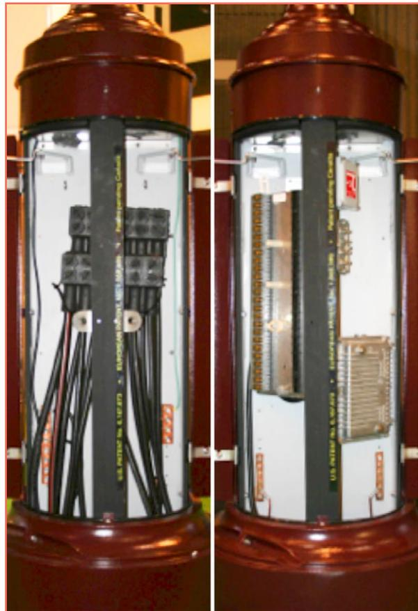
Figure 2.9: Compartiments de la borne de raccordement commune
