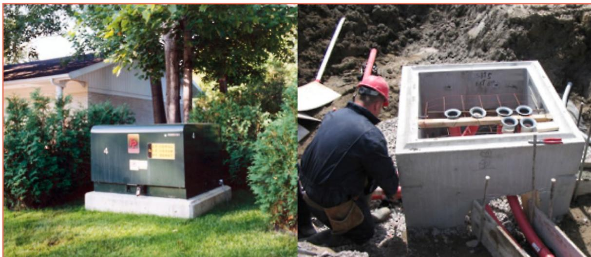
Figure 2.12: Transformateur sur socle (TSS) et socle pour poste de transformation
