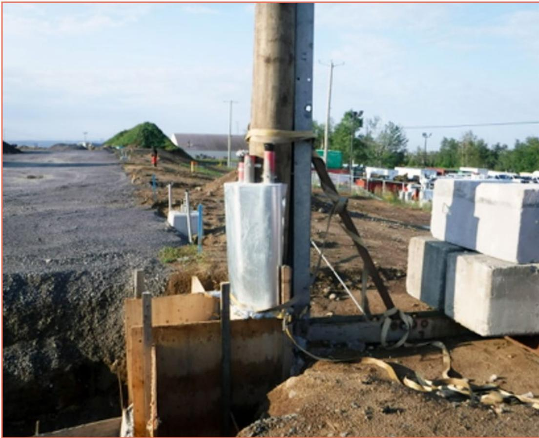
Figure 2.3: Liaison aérosouterraine (1 conduit pour l'électricité)
