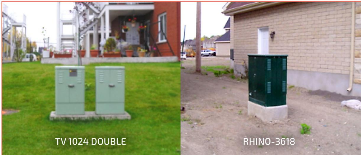
Figure 2.13 : Piédestaux sur socle pour appareillage hors sol
