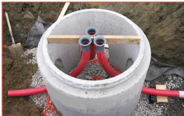
Figure 2.7: Puits de jonction (boîte de raccordement / PAC)
