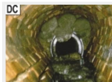
Passage d'une section de tuyau de forme ovoïde à la forme circulaire
