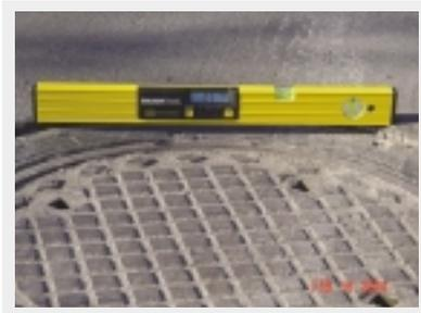
Le tampon n'est pas stable dans le cadre et émet des bruits au passage des véhicules
