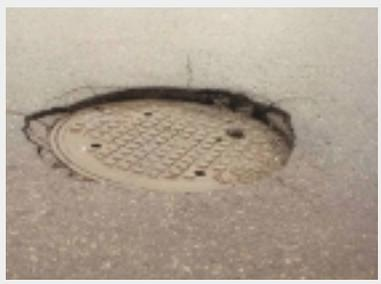
Le niveau supérieur du tampon est inférieur au niveau du pavage.
