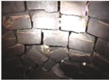
Perte de Mortier entre les briques de la composante, mais les briques sont encore en place.
