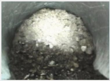
L'inspection télévisée se déroule normalement d'un regard à l'autre, dans le sens du courant, ou vers un point haut obstrué par un bouchon.
