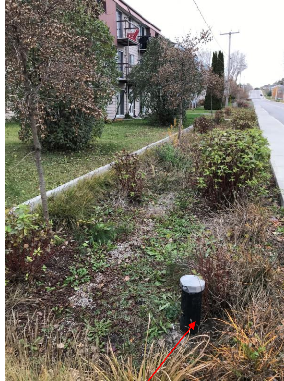
Piezomètre (point d'accès à l'eau souterraine)
