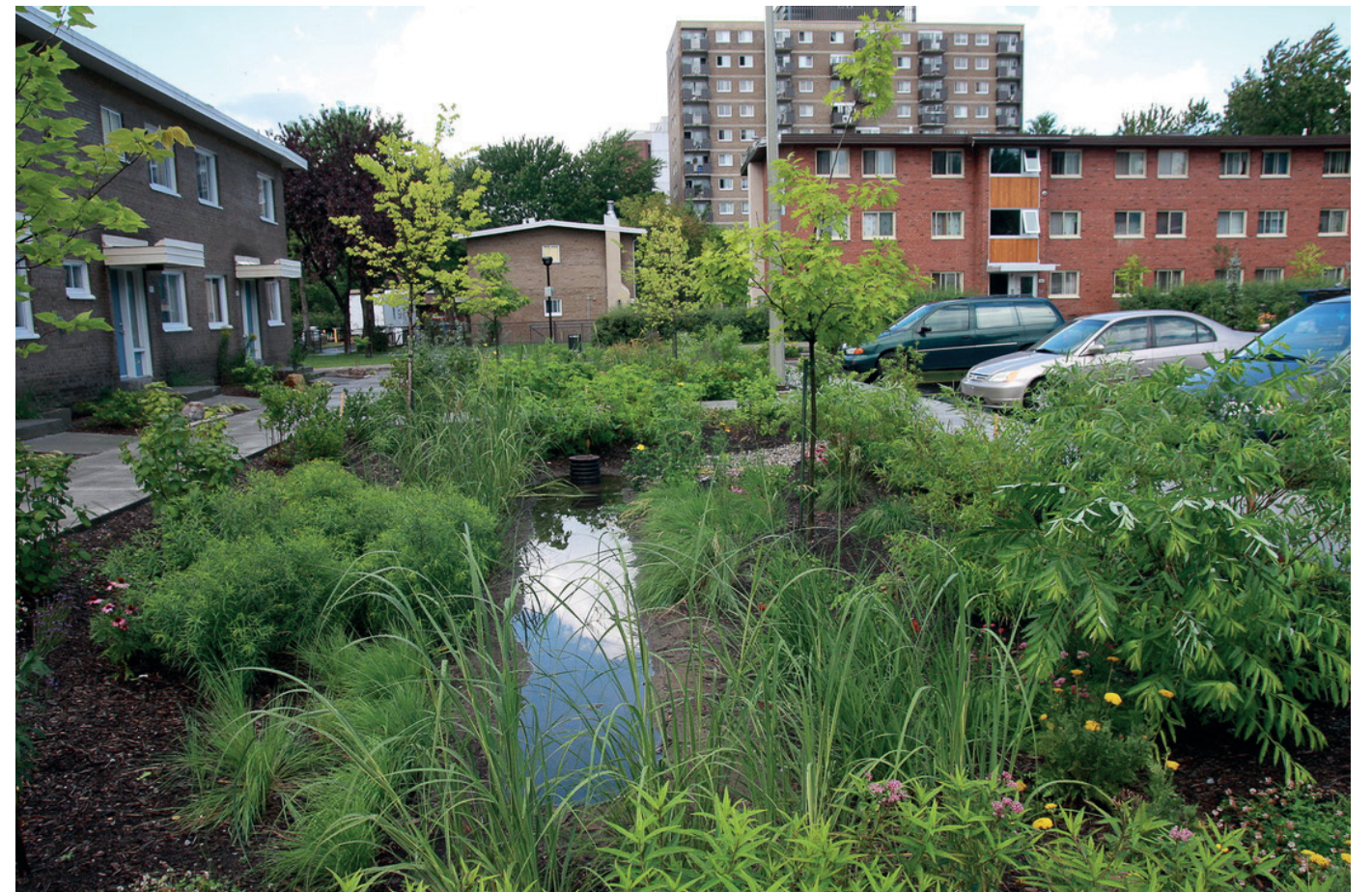
Gestion durable de l'eau pluviale aux habitations Jeanne Mance © Les Ateliers Ublo
