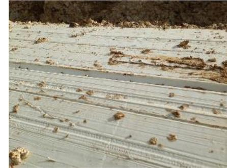
Endommagement de l'ouvrage lié à une **surépaisseur du revêtement : fissuration**
