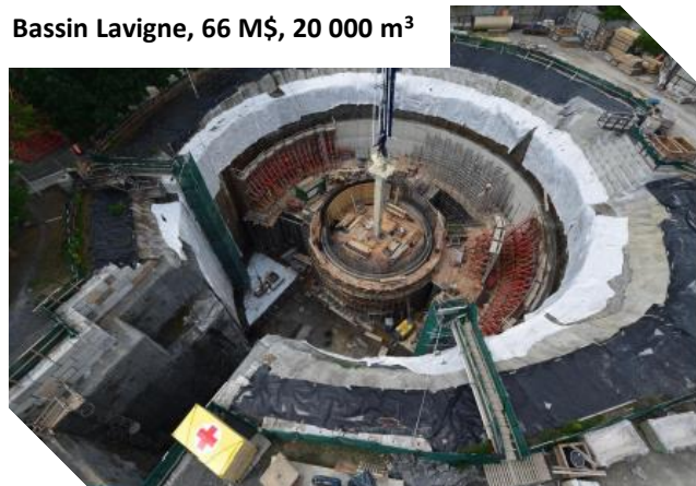
Ouvrages de rétention en cours de finalisation de réalisation (date de livraison 2023)
