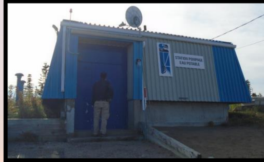
Traitement et distribution d'eau potable Collecte et traitement des eaux usées
