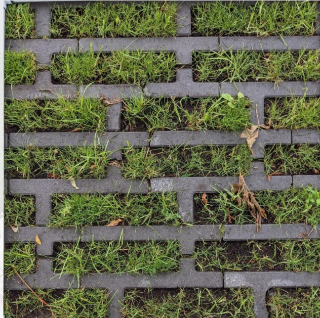
Pavage engazonné Été 2021
