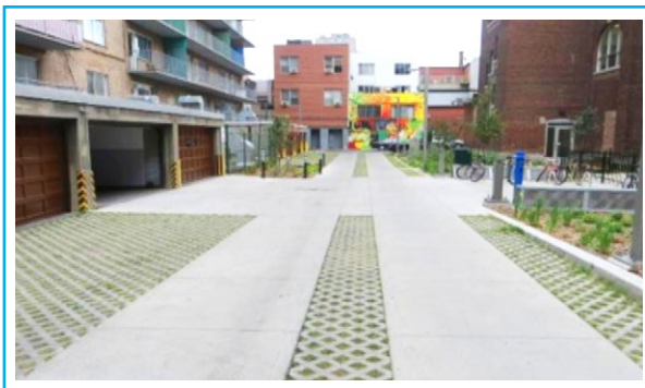
Figure 10.4: Aménagement absorbant (Ville Marie, QC, Canada)
