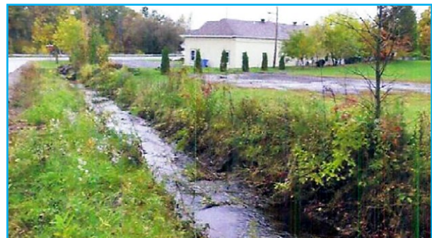
Figure 1.5: Perte de capacité d'un fossé et inondations à proximité suite à l'absence d'entretien d'un fossé
