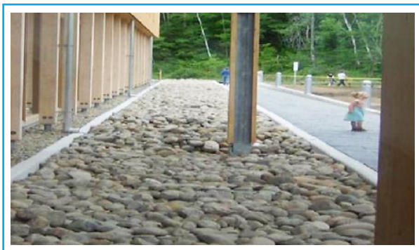
Figure 10.3: Tranchée d'infiltration (Saint-Jean-de-Matha, QC, Canada)
