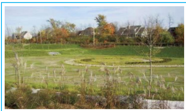
Figure 10.7: Bassin de rétention (Boucherville, QC, Canada)
