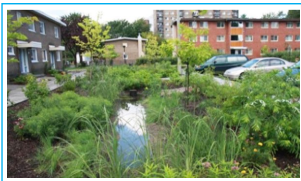
Figure 10.2: Biorétention en milieu urbanisé (Montréal, QC, Canada)
