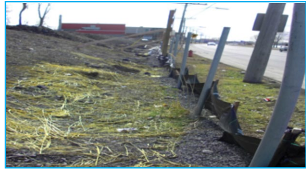
Figure 7.2 : Délimitation des zones d'excavation et du terrassement (Écocentre LaSalle, QC, Canada)
