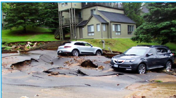
Figure 1.4: Pluie abondante et inondation – juin 2022, Mont-Tremblant
