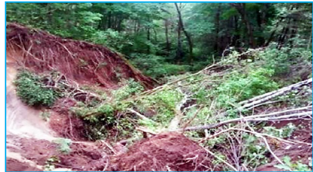
Figure 1.3: Érosion en aval d'un cours d'eau à la sortie d'un ponceau
