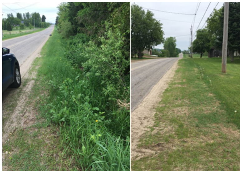
Figure 26. a) et b) - Exemple de cas où le nettoyage des fossés serait nécessaire ; Cas où le profilage de fossés serait nécessaire
