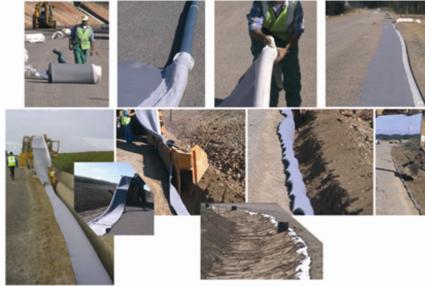
Fig. 5.8 Exemple d'application d'un drain latéral
