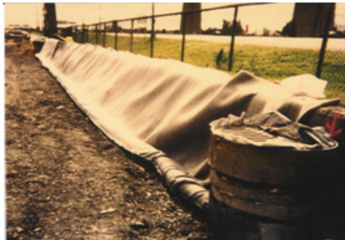
Fig. 5.7 : Écran de rive ou drain latéral
