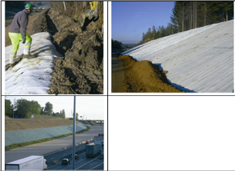
Fig. 5.6 Exemple de masque drainant de rive
