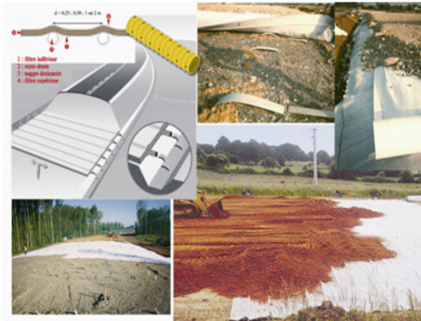
Fig. 5.9 Exemple de drainage horizontal sous remblai
