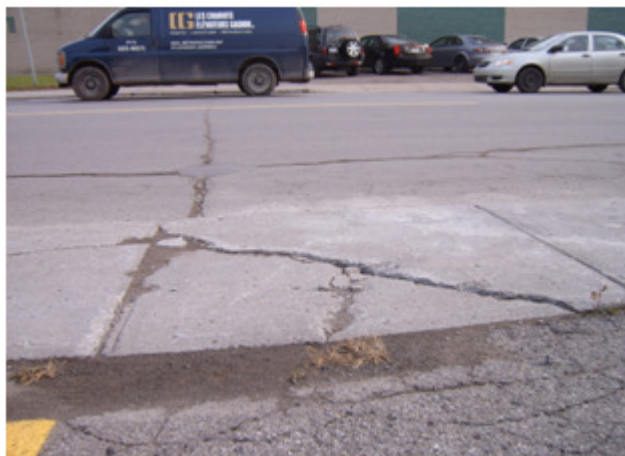
Figure A.1 : Trottoir à pente inverse
