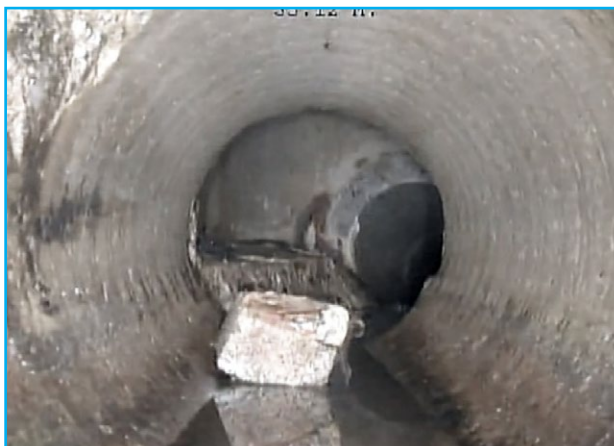
Figure 7 : Exemple d'obstruction
