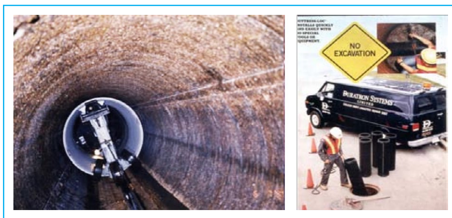
Figure 45: Exemple de tubage segmenté
