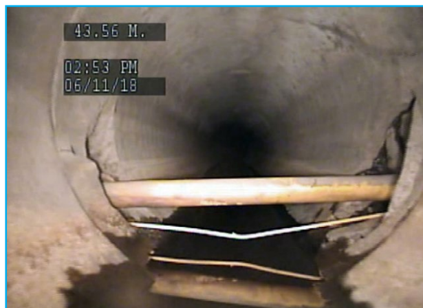
Figure 8 : Croisement d'égout (crédit-photo : Énergir)
