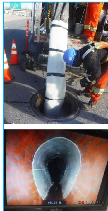
Figure 49: Exemple de chemisage ponctuel
