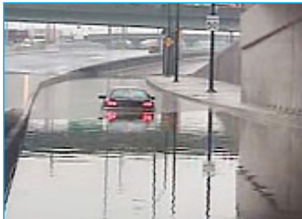
Figure 2: Inondation d'une autoroute en raison d'un manque de capacité de l'égout
