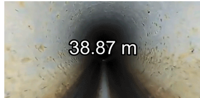
Ci-dessus : images d'inspection issues du domaine municipal.
