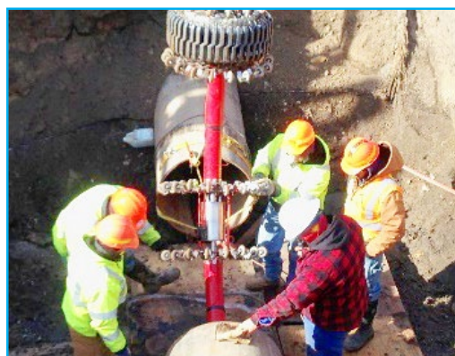
Figure 3.12 : Installation de l'équipement (PICA)
