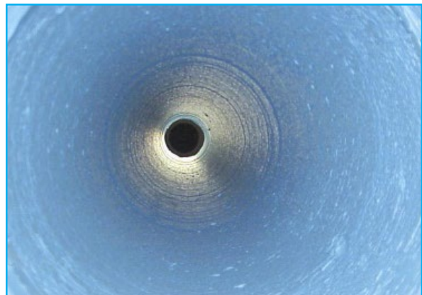
Figure 6.6: Projection avec époxy
