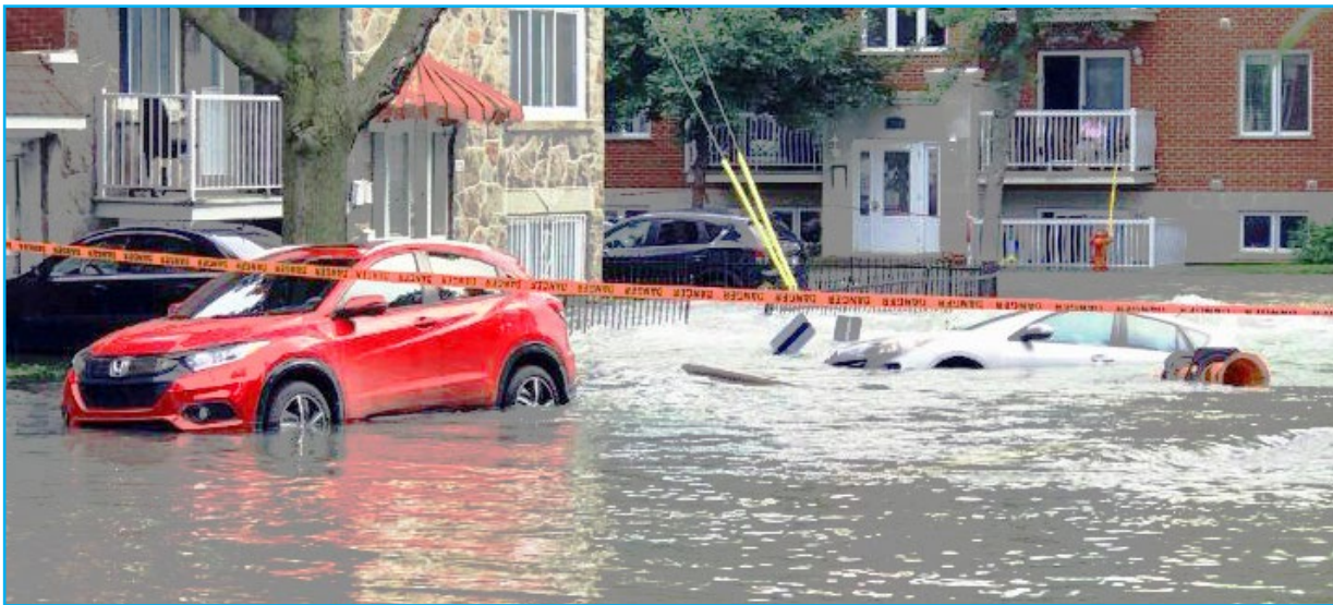
Figure 1.9: Bris majeur d'une conduite d'eau potable (CTV News) 3
