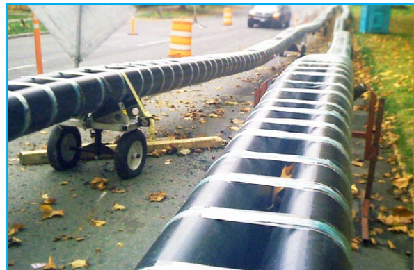
Figure 7.5: Tubage déformé (Consultants GAME)
