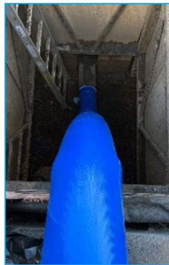
Figure 7.2: L'équipement de l'insertion par projection (Consultants GAME)
