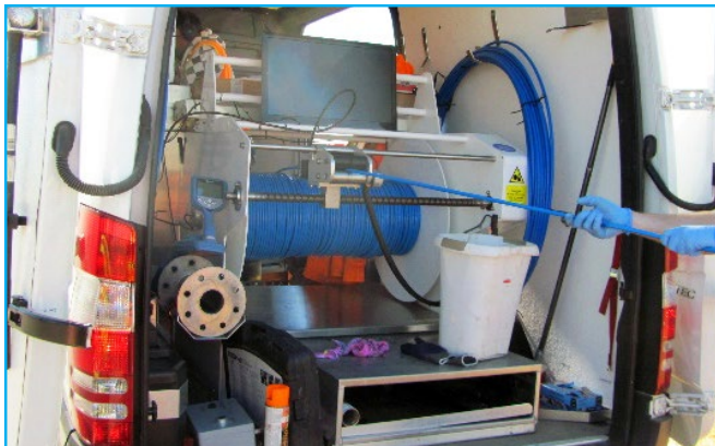
Figure 3.7: Inspection et détection de fuites sous pression (Consultants GAME)
