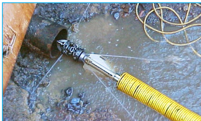
Figure 6.1: Nettoyage à jet d'eau à haute pression (Consultants GAME)
