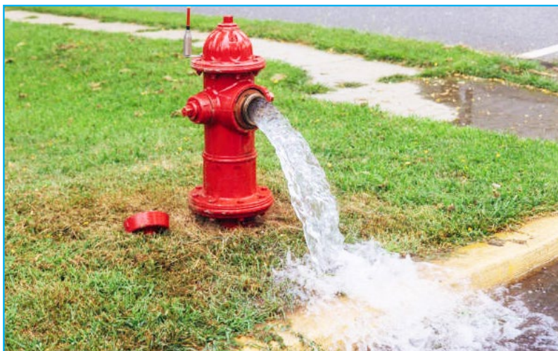
Figure 1.1: Faible débit dans une conduite d'incendie
