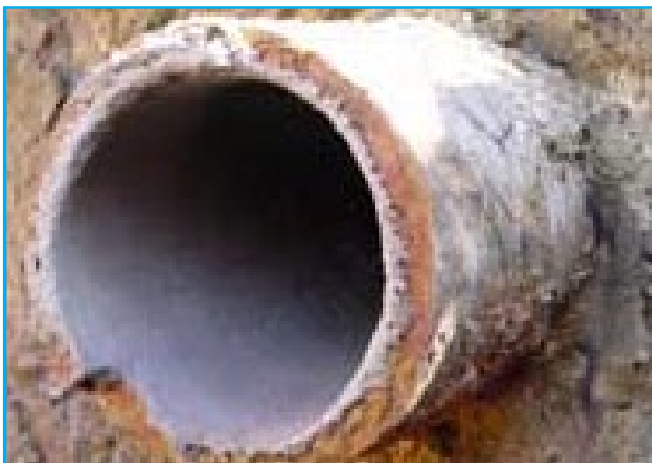
Figure 6.5: Projection avec mortier de ciment
