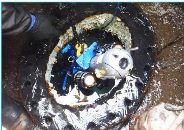
Figure 3.5: Inspection autottractée pour grand diamètre – équipements (Consultants GAME)
