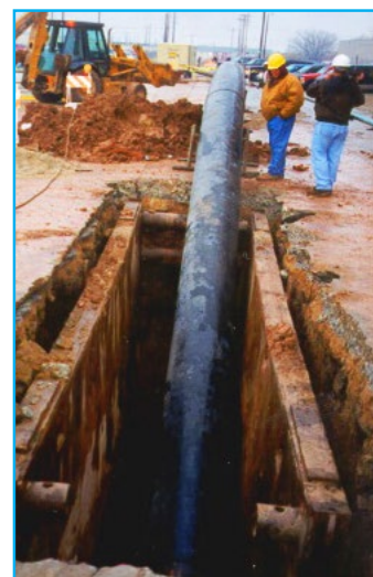
Figure 7.9: Installation de conduite en PEHD conventionnelle
