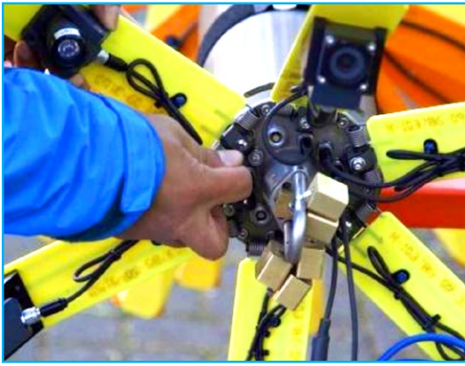
Figure 3.13 : Procédure d'installation du câble précontraint (Xylem)
