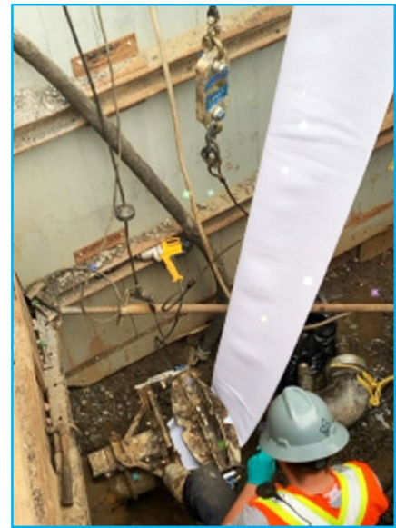
Figure 7.3: Insertion de la gaine par tirage (Ville de Montréal)
