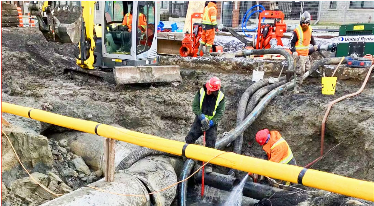
Figure 1.5 : Exposition d'infrastructures souterraines
