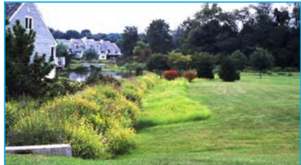
**Figure 7.4 :** Maintien du drainage naturel (SMCGIC, 2008)
