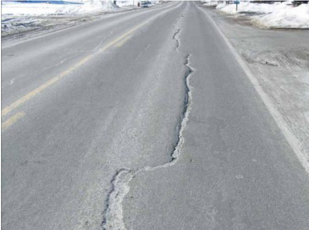
a) Lézarde associée au gel dans le sol d'infrastructure (Carrier et al. 2007).
