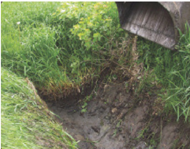
Figure 17: Exemple d'entretien de fossé avec la méthode du tiers inférieur.
