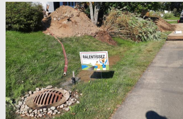
Noue colmatée à cause de travaux de construction privée
