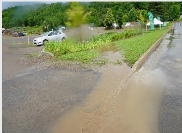
Ouvrage sous-dimensionné
