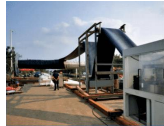
Réhabilitation d'une conduite d'eau DN800, 1Mpa, 1250m Tangshan Water
