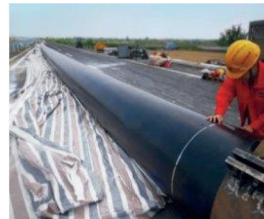
Réhabilitation d'une conduite d'eau DN800, 1Mpa, 1250m Tangshan Water
