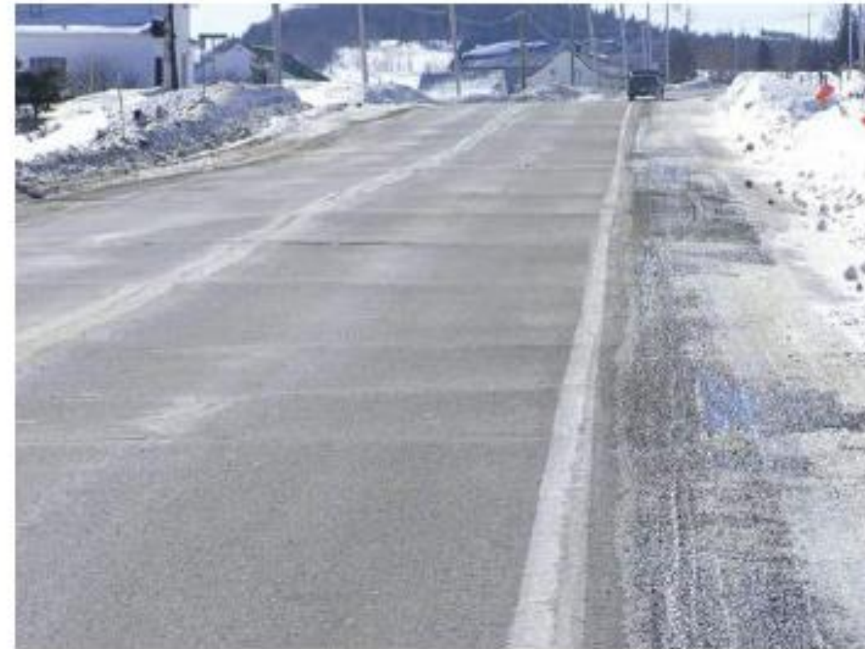
b) fissures et soulèvements de faible amplitude associés au gel dans la structure de chaussée (Carrier et al. 2007).
