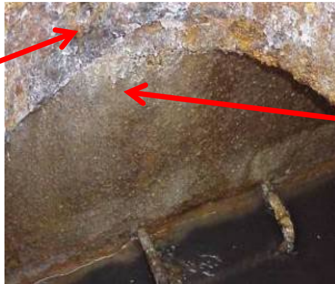
SewperCoat® demeure solide, alors que le cadre en fonte ductile revêtu d'époxy est gravement détérioré
