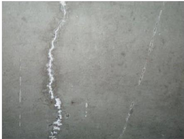
Autocicatrisation d'une fissure circulaire
