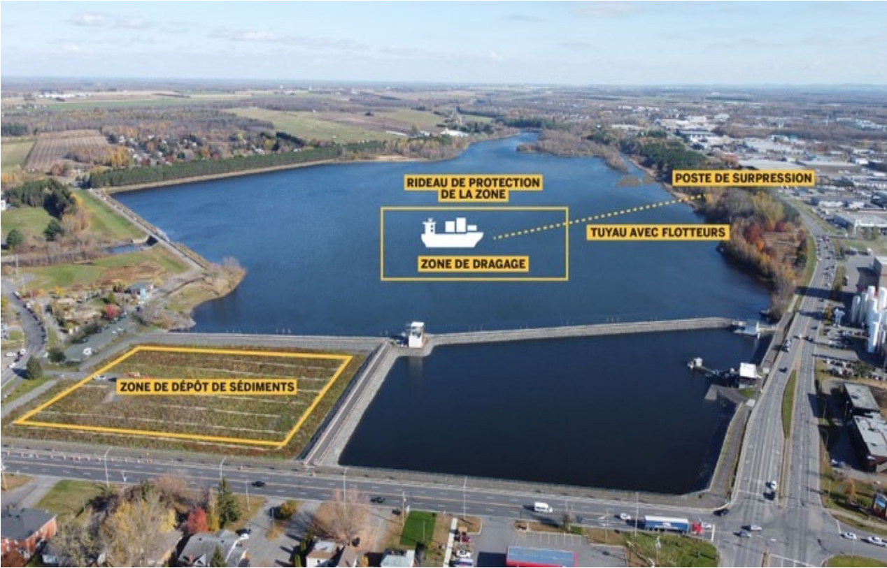
Cas du réservoir Beaudet à Victoriaville (eau potable) : envasement -> 40M$ pour dragage et gestion des sédiments.
