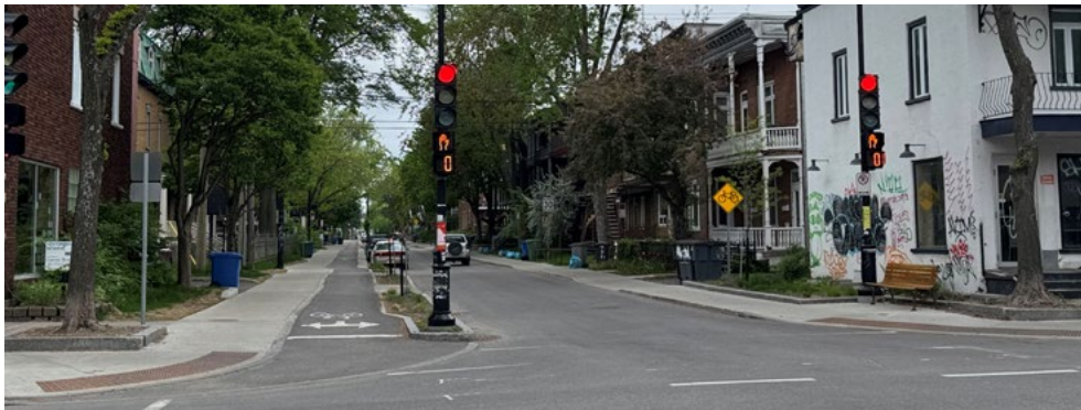
Figure 15 – Piste cyclable avec zone tampon, Vieux Limoilou, Québec. Crédit photo: Michèle St-Jacques.
