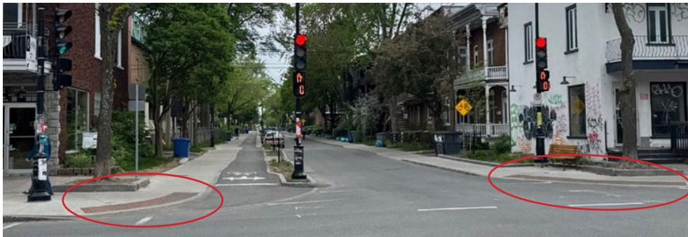
Figure 12 – Plaques podotactiles, 3 e Avenue, Vieux-Limoilou, Québec. Crédit photo : Michèle St-Jacques
