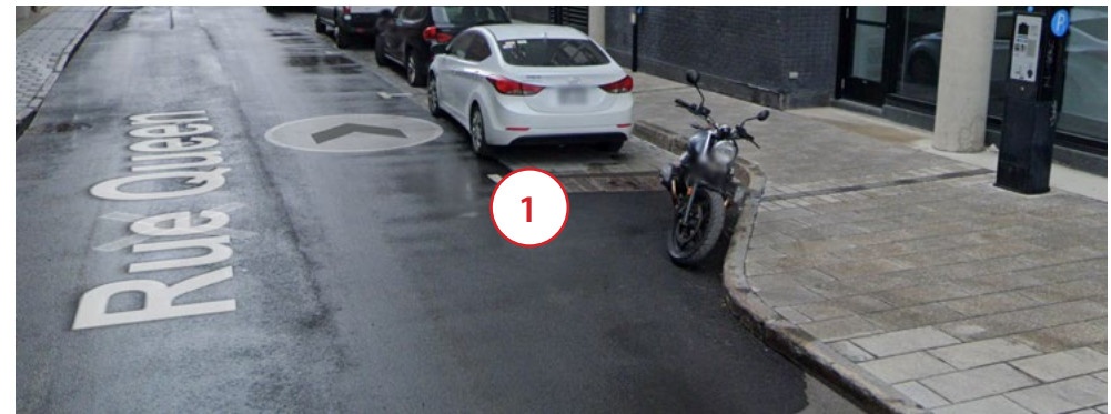
Figure 8 – Stationnements matérialisés avec dégagement visuel via saillie pavée, rue Queen, Montréal. Source : adaptée de Google Street View
