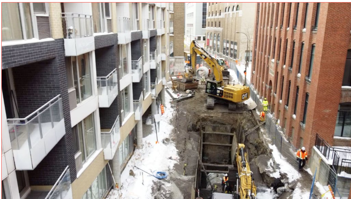
Figure 2.5: Excavation à proximité d'infrastructures souterraines
