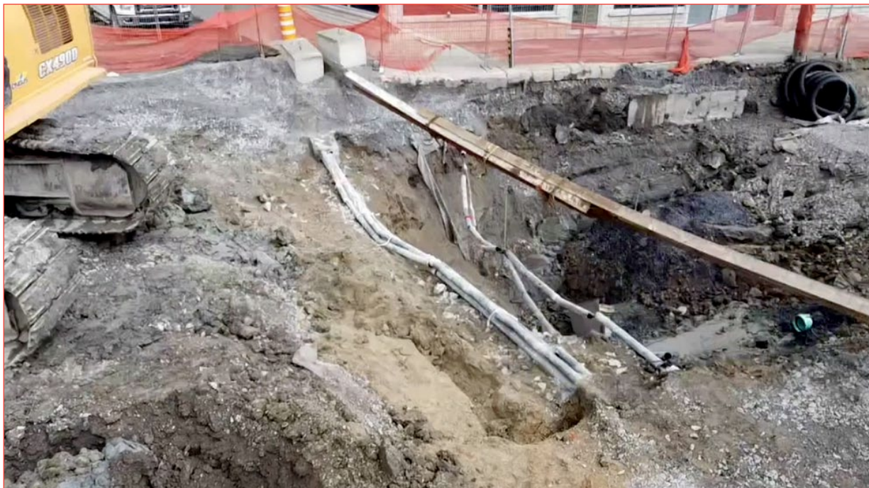
Figure 2.6 : Infrastructures exposées et protégées lors des travaux
