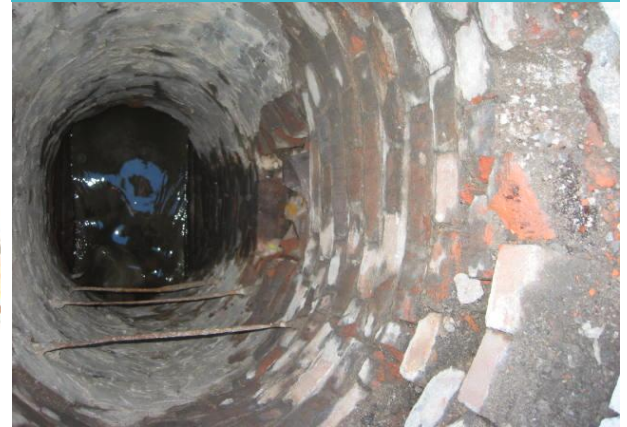
Réparation des joints de briques
