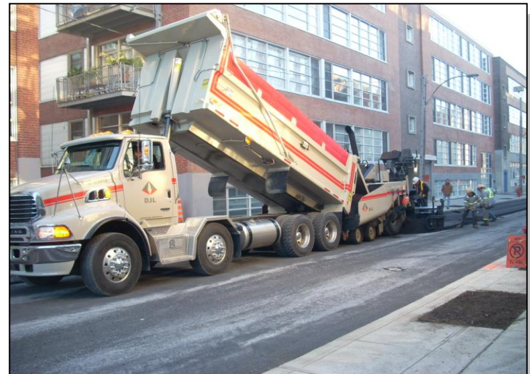
Pose d'ÉCOLVIA sur une couche d'accrochage spéciale
