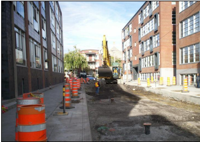
Moins de travaux d'excavation grâce au concept de chaussée TFE
