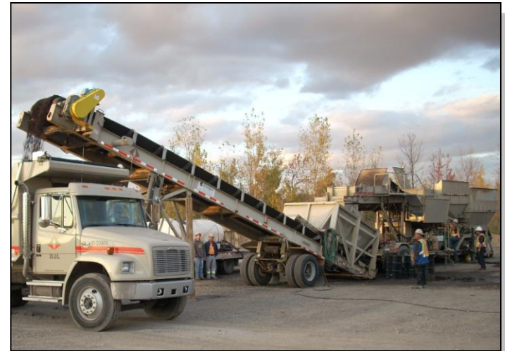
Production de mélange à froid avec un matériel de chantier mobile
