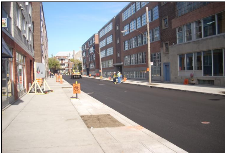
ÉCOLVIA après compactage
