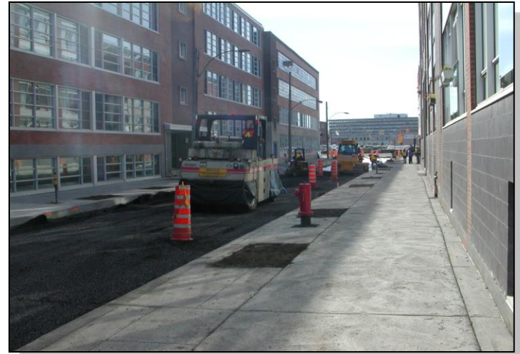
Compactage du RECYFLEX FD
