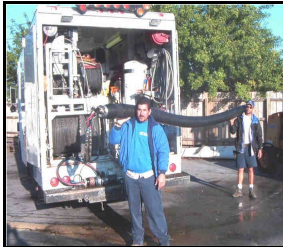
Packer d'injection pour fissures longitudinales
