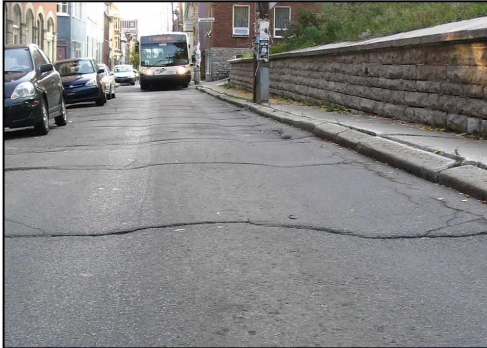
Déformation permanente
