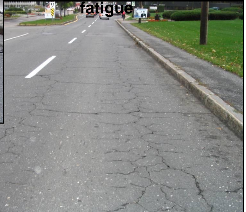
Fissuration par
